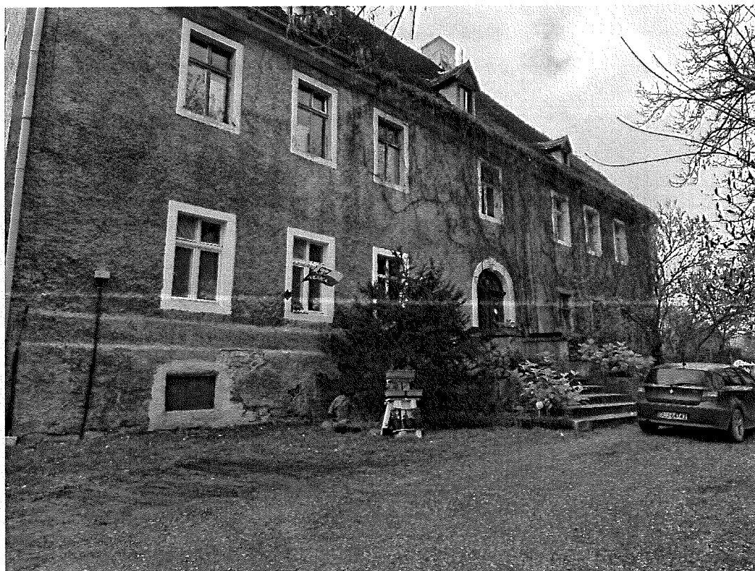
Dawna szkoła (dziś budynek mieszkalny)
